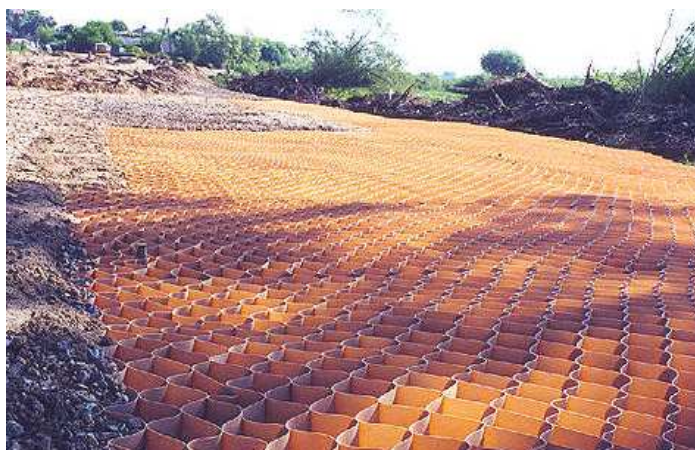
Wzmocnienie skarpy i zabezpieczenie przeciwerozyjne systemem geokraty
